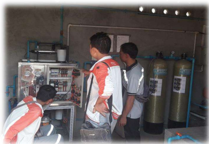
ပုံ- ကူပြင်ကျေးရွာရှိ သောက်ရေသန့်စက်တွင် ပြုပြင်ရန် လိုအပ်သော Magnetic connector အား ဝယ်ယူ၍ တပ်ဆင်ပေးခြင်း။
