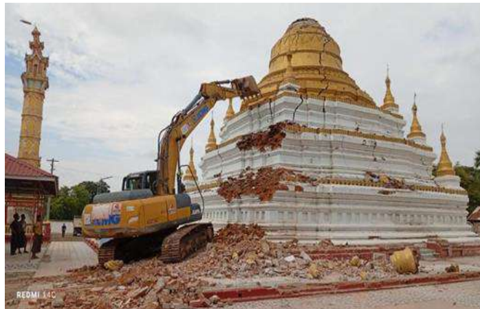
ပုံ- သာစည်မြို့နယ်၊ လှိုင်းတက်ကျေးရွာ၊ ငလျင်ဘေးဒဏ်ကြောင့် ထိခိုက်ပျက်စီးသွားသော ရွှေဆင်းလှဘုရား ရှင်းလင်းရေးလုပ်ငန်း အတွက် စက်ယန္တရားကြီးများ အသုံးပြု၍ ကူညီပေးခြင်း။
