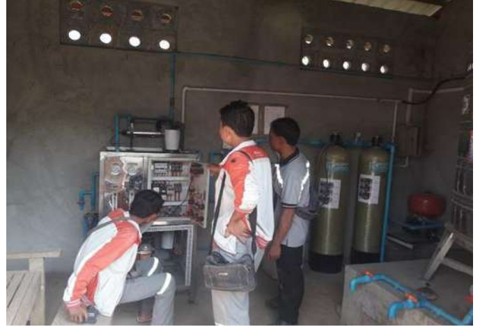
ပုံ- ကူပြင်ကျေးရွာရှိ သောက်ရေသန့်စက်တွင် ပြုပြင်ရန် လိုအပ်သော Magnetic connector အား ဝယ်ယူ၍ တပ်ဆင်ပေးခြင်း။
